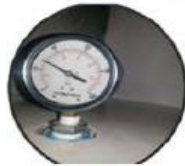
แรงดันน้ำ ก่อนปรับ 2.4 Bar
